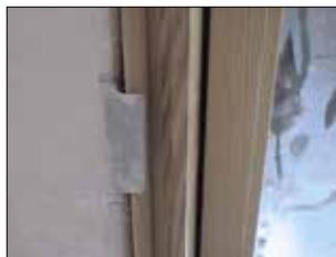
Positionner le dormant sur les 4 pattes métalliques pour le fixer.
